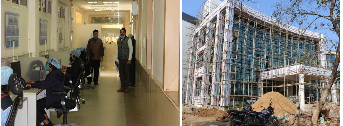
फोटो 4.1: कॉल सेंटर की अस्थायी व्यवस्था एवं निर्माणाधीन भवन
